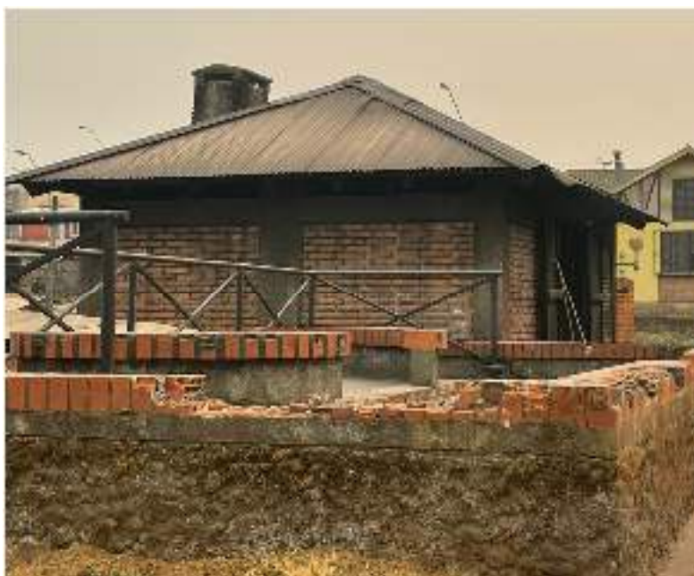
“Restauración y Habilitación Hornos y Lavadero”
