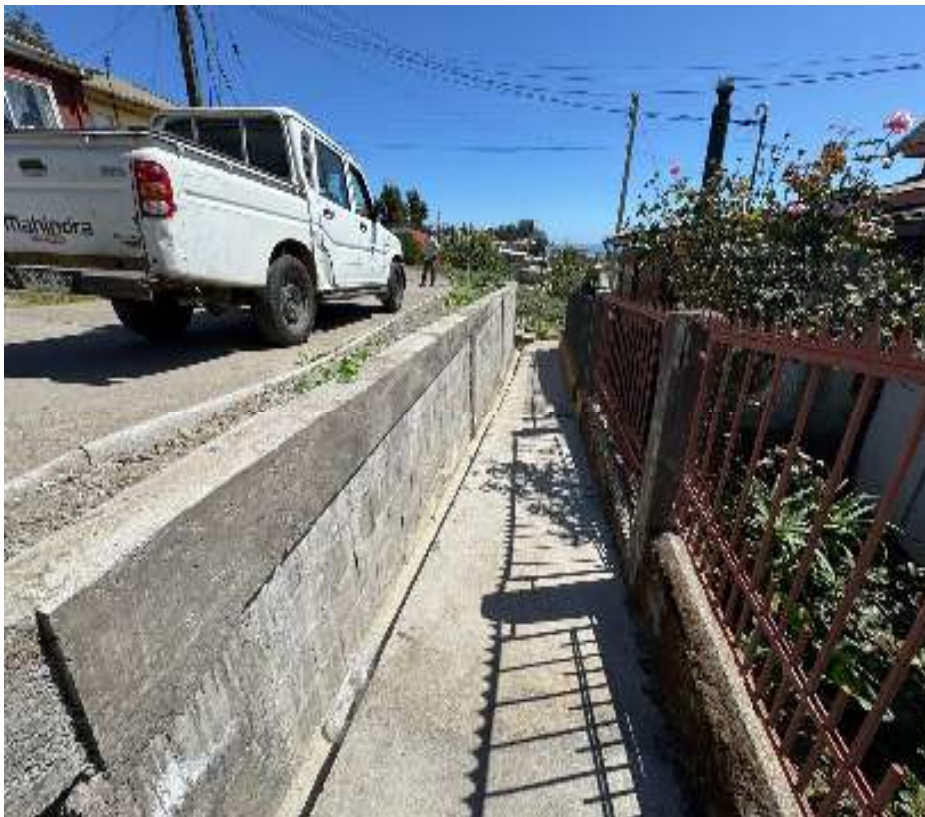
1-K-2025-78 “Construcción Muro y Mejoramiento de Acera Sector Polvorín 3, Lota.”
